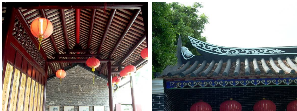
圖 95. 正廳的屋頂結構（左）及翹角形屋脊和桃形墊點（右）。
