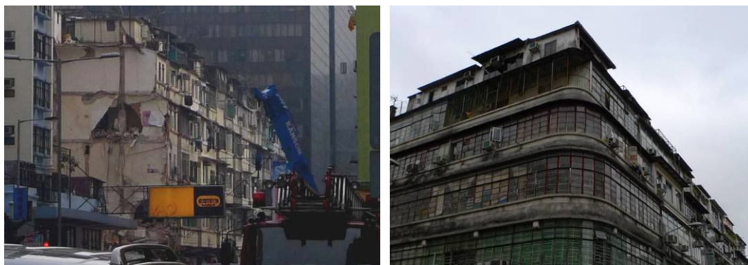
圖 235. 馬頭圍道塌樓現場，攝於12月29日(左)及區內普遍的僭建問題。
