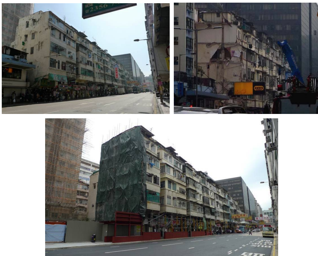
圖 190. 馬頭圍道43A-45J號塌樓前，攝於2009年12月(左)及塌樓後，攝於2010年1月29日(右)及3月29日(下)。
