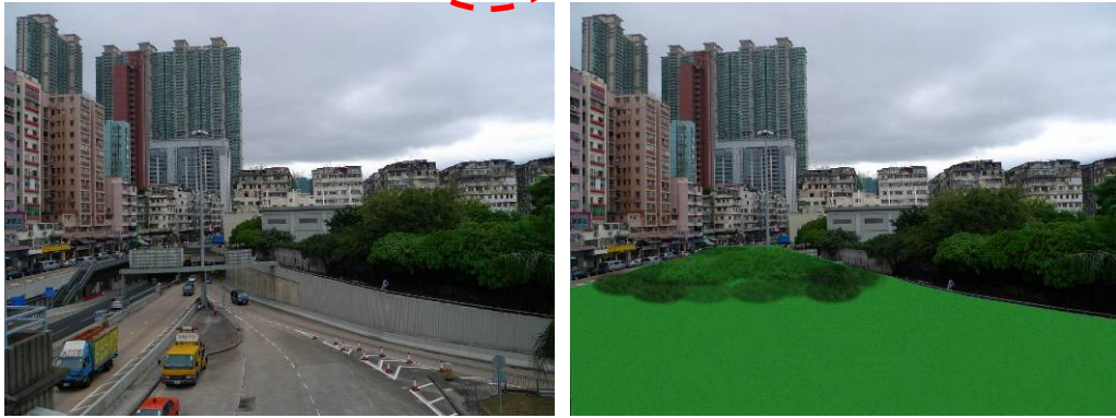
圖 222. • 啟德隧道下沉段加建綠色上蓋。
