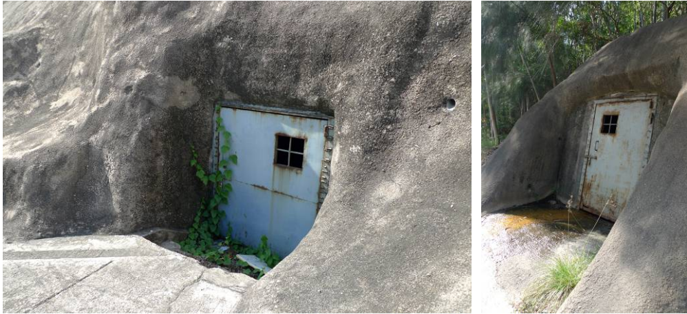
圖 40. 位於漆咸道的防空洞出口，攝於2009年12月。
